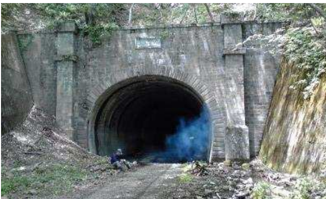
②第2代「ニツ小屋隧道」(福島側坑門) 「ニツ小屋隧道」福島側坑門を望む。
