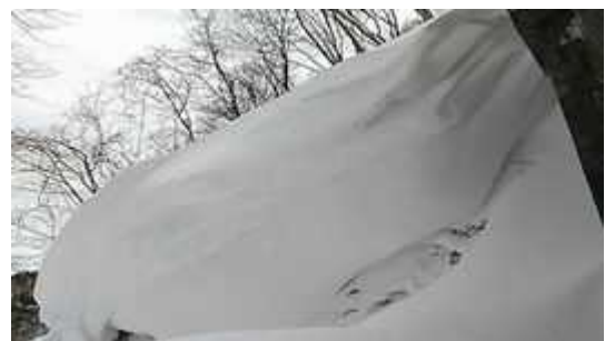
写真 9— 2B 米沢側坑口前の巨大雪庇。坑内から望む。
