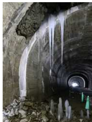
写真7-2 覆工崩壊箇所のつららと氷筍。 第4号内巻区間、米沢側端部。 米沢側から望む。
