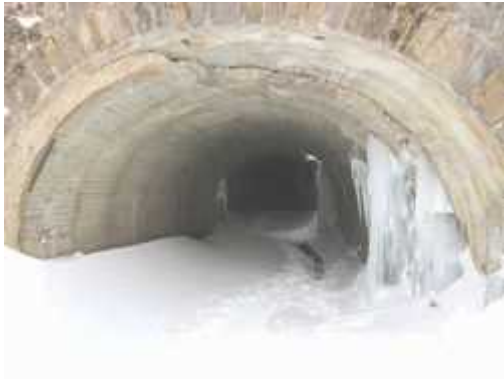
写真 8 —3A 米沢側坑口から坑内を望む。 右手前の氷柱は、以前は小さく目立たなかったもの。
