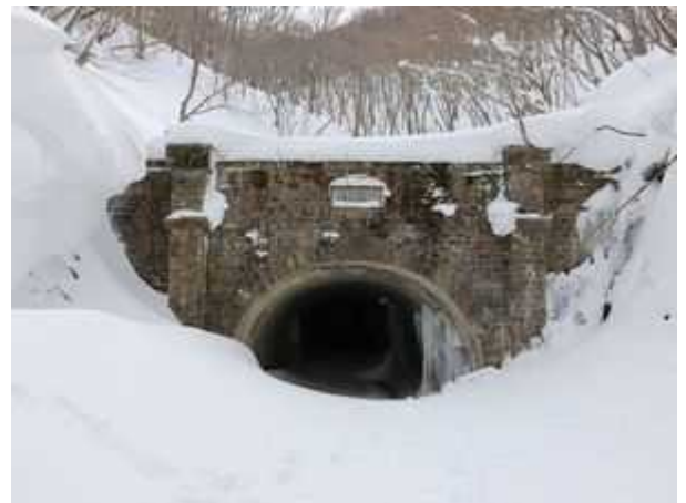
写真 9 —1 米沢側坑口。雪深し。
