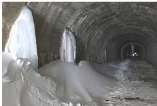
写真 8 —4B 第 6 号内巻区間(米沢側坑口から約 80m)中間部から 福島側を望む。奥に見えるのは第 5 号内巻区間米沢側 端部(米沢側坑口から約 100m先)。
